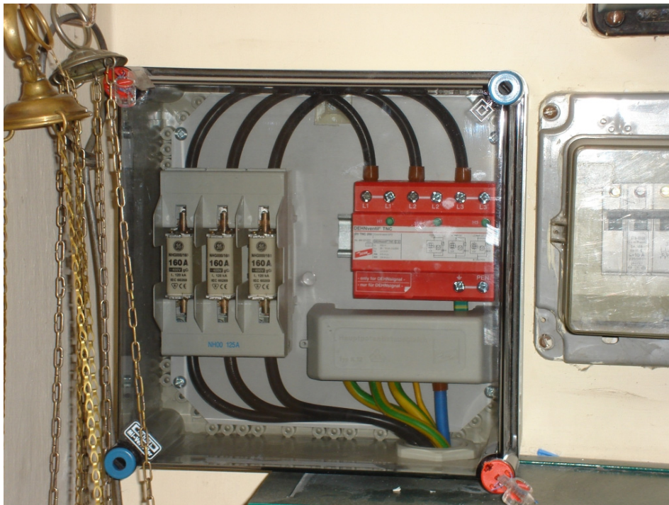
1.5 ábra: Csatlakozószekrényben elhelyezett villámvédelmi eszközök
