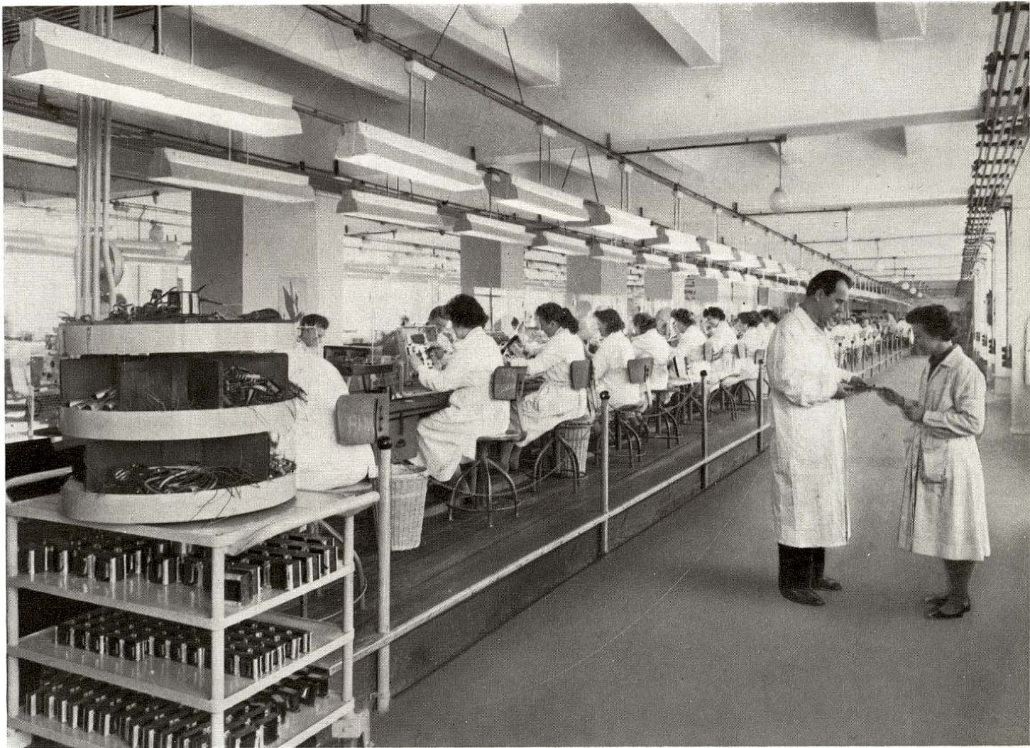
Mozgó televízió-szerelőszalag, 1960.
